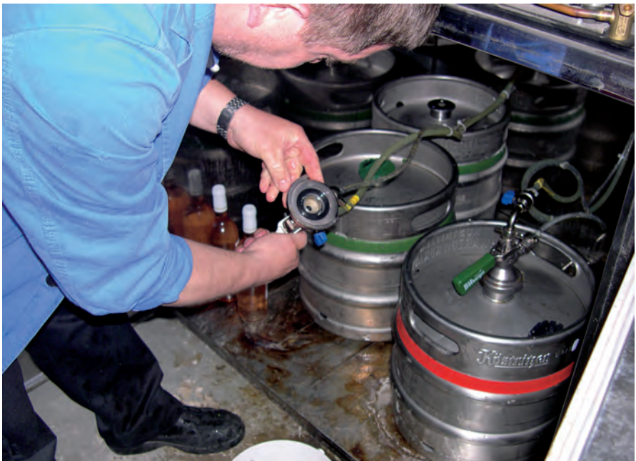
Abb. 3: Reinigung des Leitungsanschlussteiles
