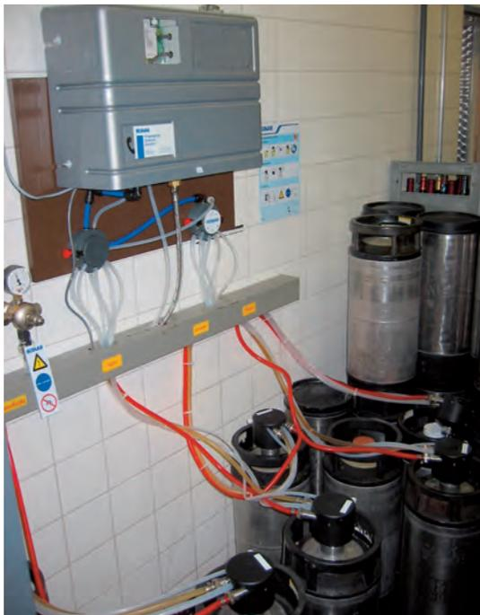
Abb. 5: Automatisches chemisches Reinigungsgerät für Getränkeleitungen (Dosiervorrichtung und Steuereinheit)
